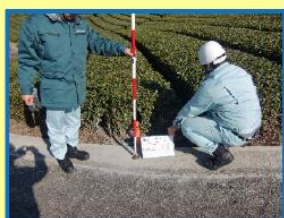
国調図根点金属標埋設の様子
