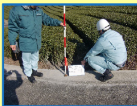
国図根点金目標埋設の様子
