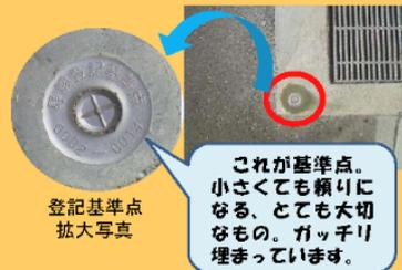
測量の基準となる登記基準点を設置し、GISという位置や空間に関する情報を処理して表示する地理情報システムに入力することにより、災害時等に境界を復元できるようにするデータ管理します。
